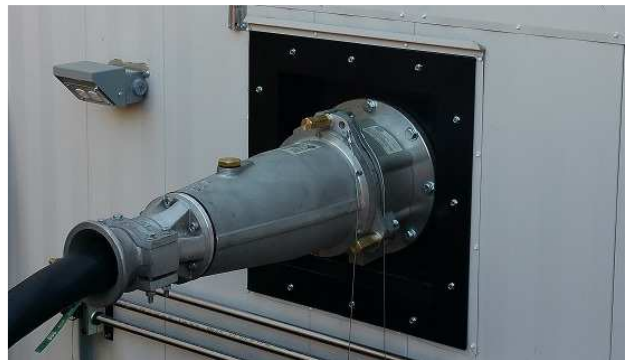
Par de Acopladores Blindados 15kV, 600A
