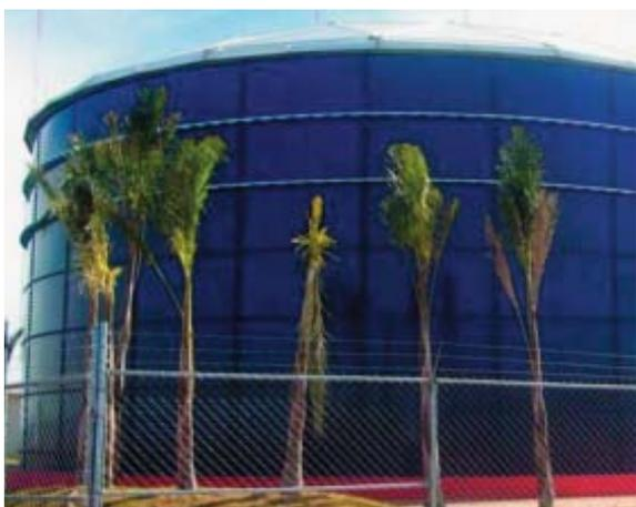
azucareros como caña de azúcar, hasta aceites vegetales o grasas de origen animal. También es necesario almacenar el producto acabado y contar con depósitos para el agua de alimentación y agua contra incendios en planta. Los tanques y silos modulares BIOTANQ® se pueden utilizar en estos ámbitos proporcionando beneficios significativos en comparación con las estructuras soldadas tradicionales.
