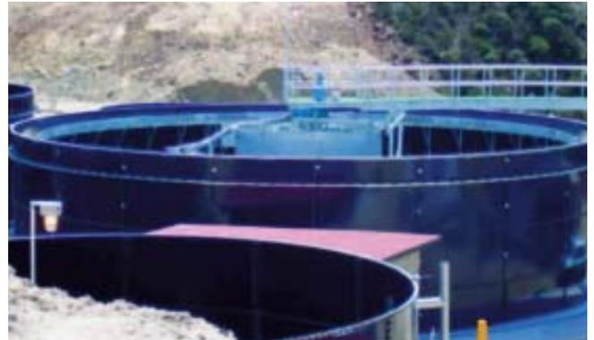
Los tanques de Vidrio Fusionado al Acero tienen una alta resistencia a la corrosión y a la abrasión y entonces son idealmente apropiados para ser utilizados en aplicaciones de tratamiento de agua residuales. Algunas de estos usos incluyen:
