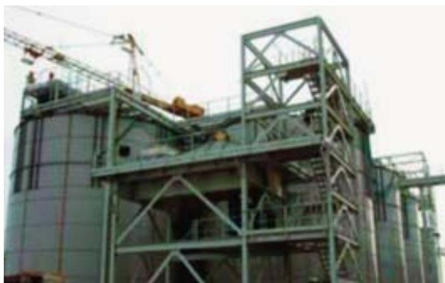
El sistema apernado de los tanques permite una rápida construcción en comparación con las estructuras soldadas. Así, también es posible desmontar los depósitos ya montados y trasladarlos a otros lugares cuando se necesite, lo cual aumenta su valor.
